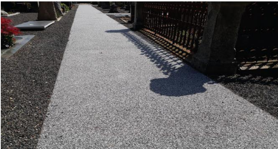
Exemple d'un revêtement drainant réalisé dans le cimetière de Jouxens-Mézery
