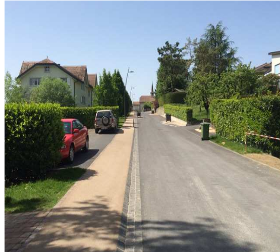
Partie ouest du Chemin des Abbesses après les travaux de réfection
