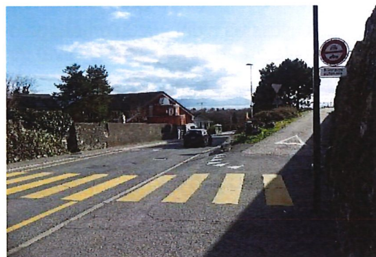
Figure 9. Passage piétons, carrefour chemin des Vignes
